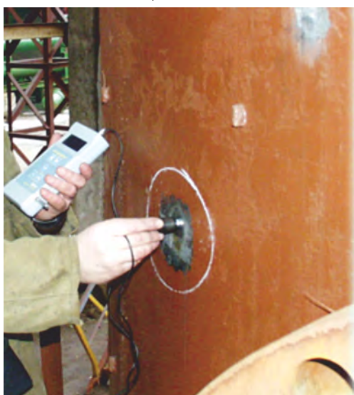
Измерение твердости переносными твердомерами
