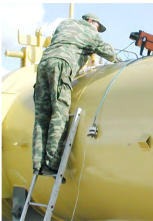
Ультразвуковой контроль сварных соединений и основного металла
