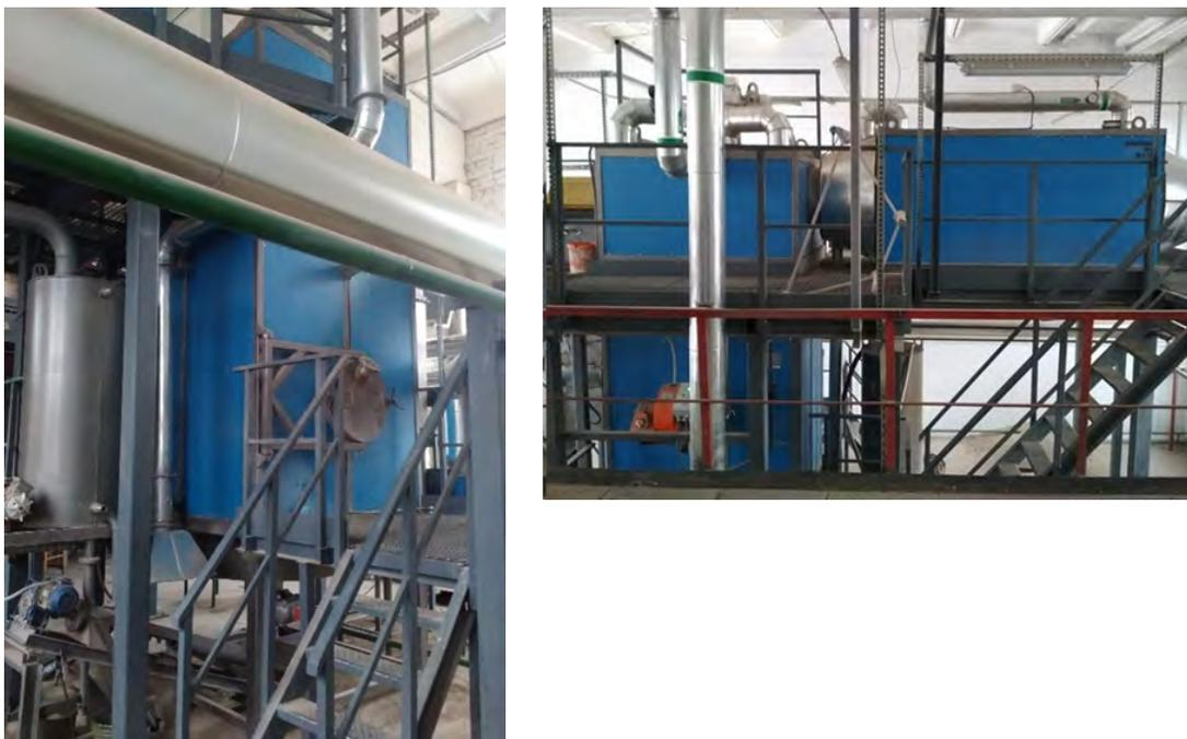
Рис. 2. Водогрейный котел мощностью 2 МВт с двухкамерной циклонно-слоевой
