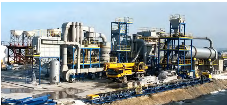
Комплекс по переработке минерального сырья, Российская Федерация
