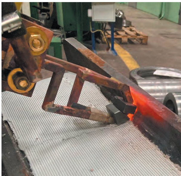
Процесс СЭТО сварного соединения элемента рамы карьерного самосвала
